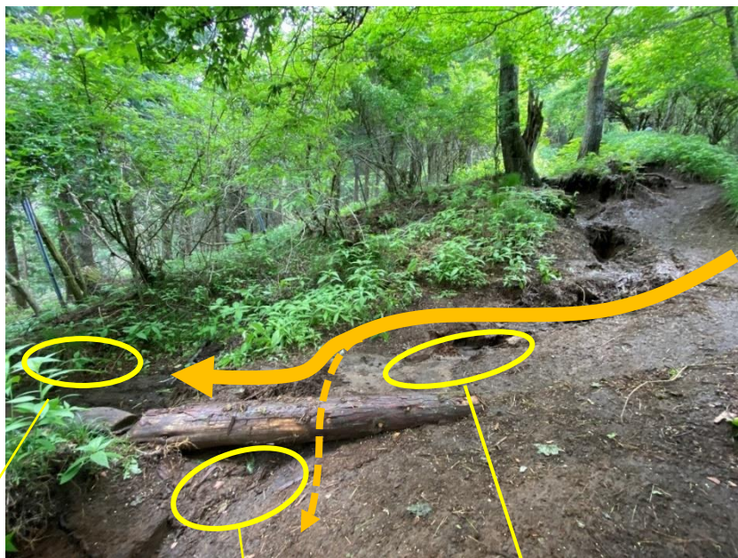
施工翌日、降雨後の導流工
